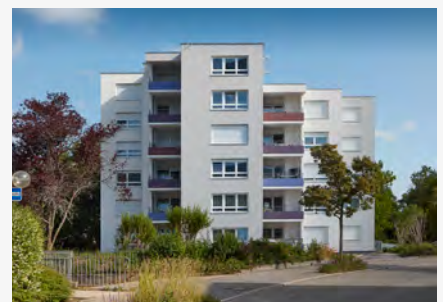
Mehrfamilienhaus In Rosenbenz 18 in Mössingen
