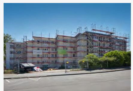
Mehrfamilienhäuser Keltensstraße 12-20 in Sigmaringen
