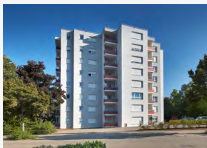
Mehrfamilienhaus In Rosenbenz 14 in Mössingen
