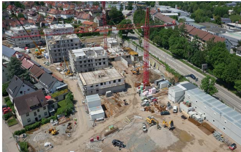
Wohnanlage „Alte Ziegelei“, Villingen-Schwenningen
