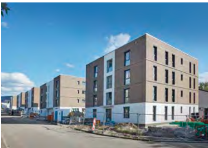
Nachhaltig Wohnen Mehrfamilienhäuser in der Eschenstraße in Mössingen
